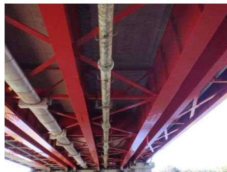
橋梁補修(塗装塗替)
