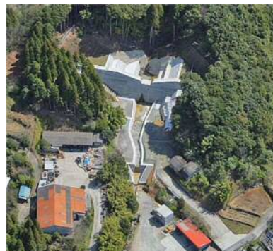
栗山追川(いちき串木野市)砂防堰堤
