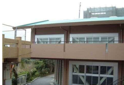
耐震改修を実施した教育施設
