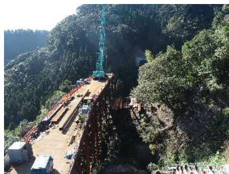
国道504号(西光寺拡幅)
