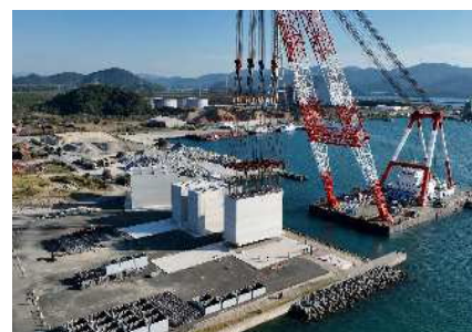
川内港国際物流ターミナル
