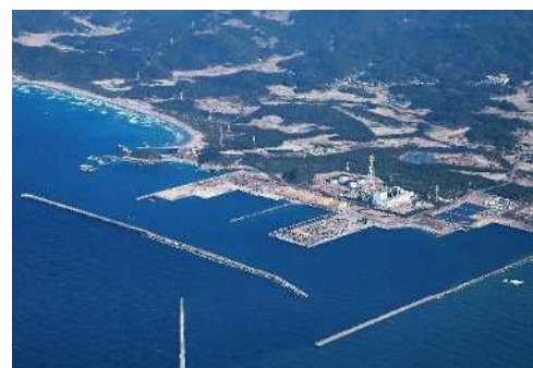
川内港国際物流ターミナル
