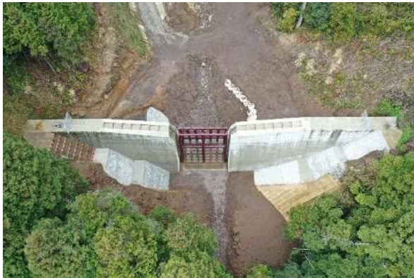
砂防施設(湧水町川西)
