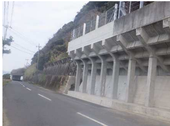
道路災害防除(根占辺田工区)
