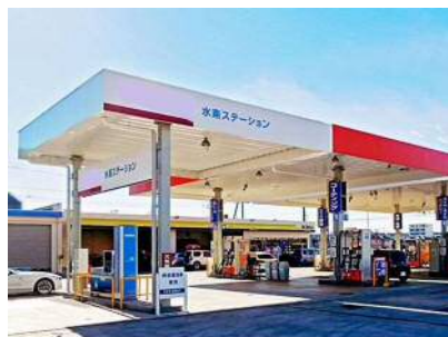
水素ステーション
