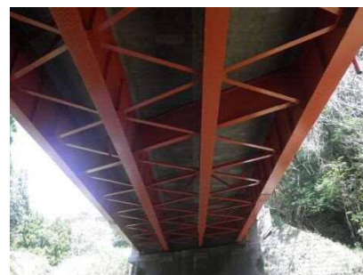
橋梁補修(塗装塗替)
