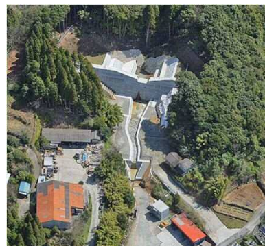
栗山追川(いちき串木野市)砂防堰堤
