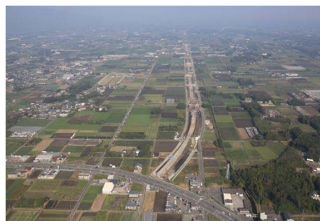
大隅縦貫道(串良鹿屋道路)
