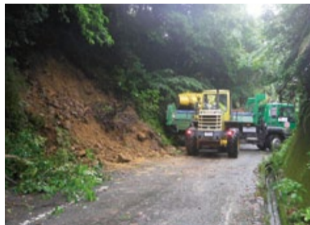
道路の崩土除去
