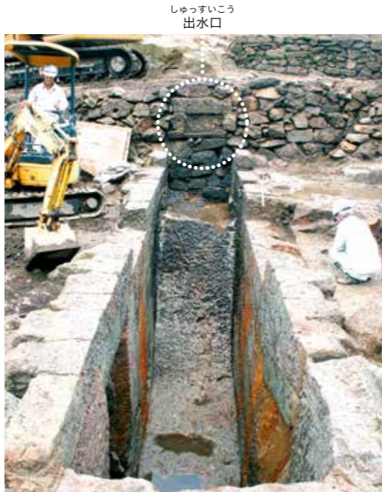
▲発見された水車坑の跡。岩盤※1を約3m削り込んで、水車※2を設置していた
