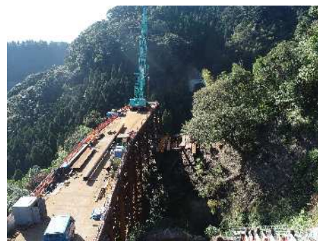
国道504号(西光寺拡幅)
