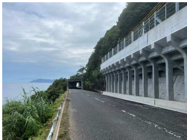
道路災害防除(根占辺田工区)
