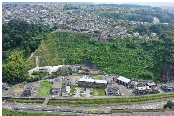
急傾斜地崩壊防止施設(田上10地区)
