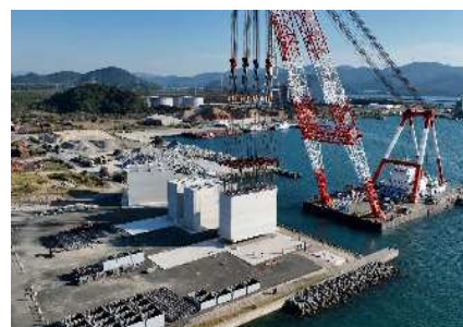
川内港国際物流ターミナル
